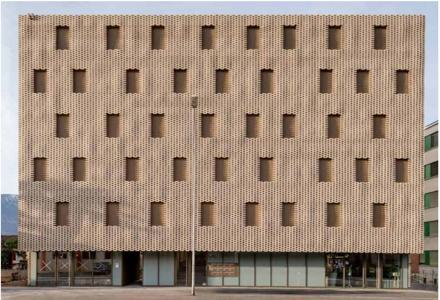
Le Stelle in Locarno met een gevel uit 700 gelijkde baksteenelementen.
