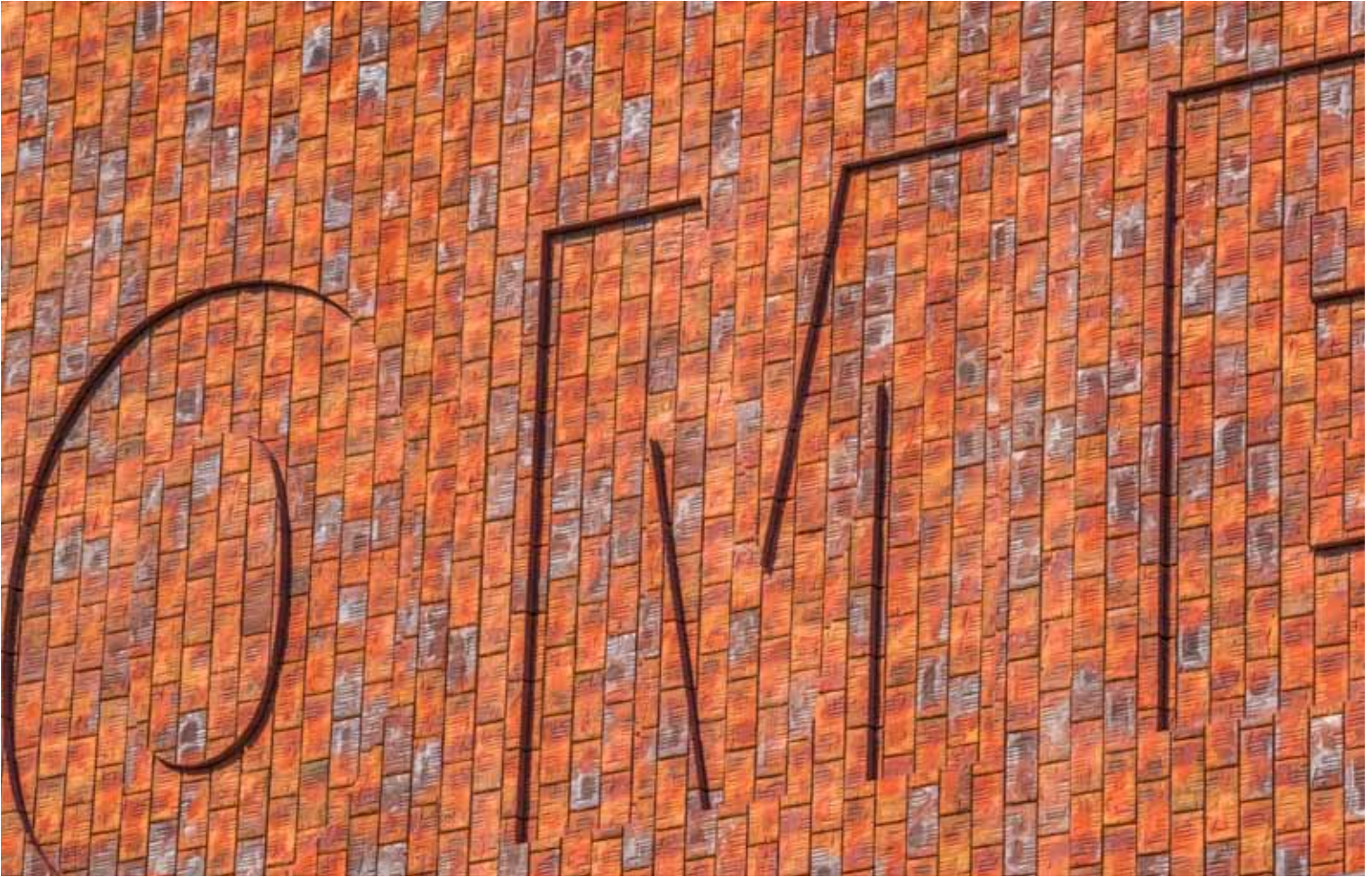
Met hogedrukwatersnijden is in reliëf het woord 'Promenade' getekend.
