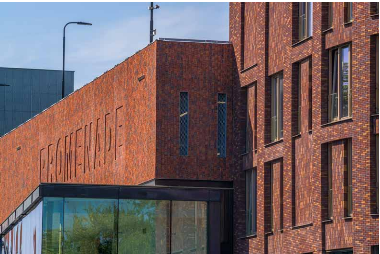
De oranje prefab gelijkde delen zorgden voor een aanzienlijke gewichtsbesparing.
