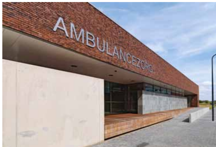
De stenen zijn in het werk gelijmd.
