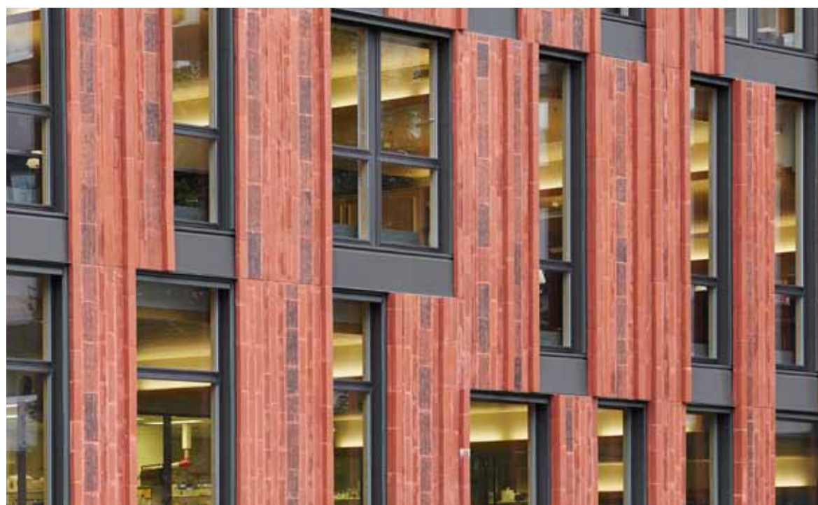
Een holle steen in staandverband en dubbelblok maakt een 3D-gevel.
