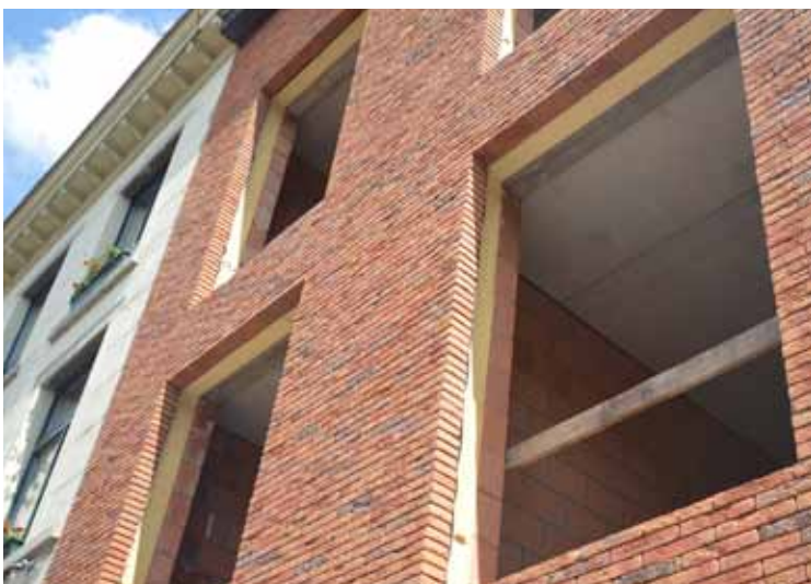
Lijmwerk maakt gevelopeningen zonder latei mogelijk.
