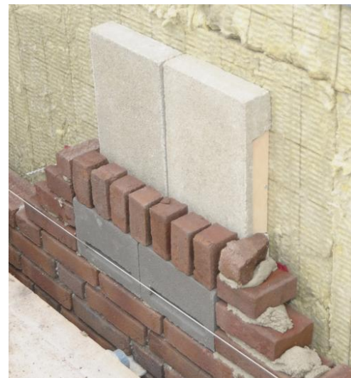
Inmetselen van prefab vleermuiskasten
