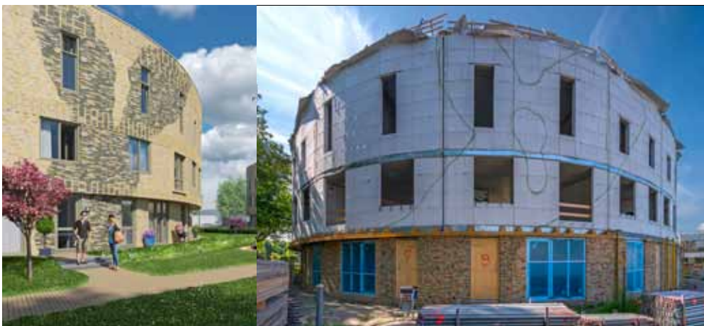
Artistieke impressie van project Wonen in de Plataan, Italiëlaan Haarlem van Heren 5 Architecten. Momenteel in uitvoering. Voor de metselaar is met spuitbus de contour aangegeven van het platanenmotief dat op de gevel moet verrijzen. Foto: johnlewismarshall.com
