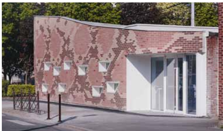
De slangenleren baksteen gevel definieert het gebouw.
