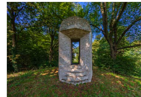
Links. Brug- en transformatorhuis ‘t Melkhuisje Haarlem. De Koepel in Heemstede (rechts) bestaat geheel uit tweedehands ijsselstenen. Bij gebrek aan speciale hoekstenen zijn de baksteenranden van de Koepel gezaagd en getrommeld.
