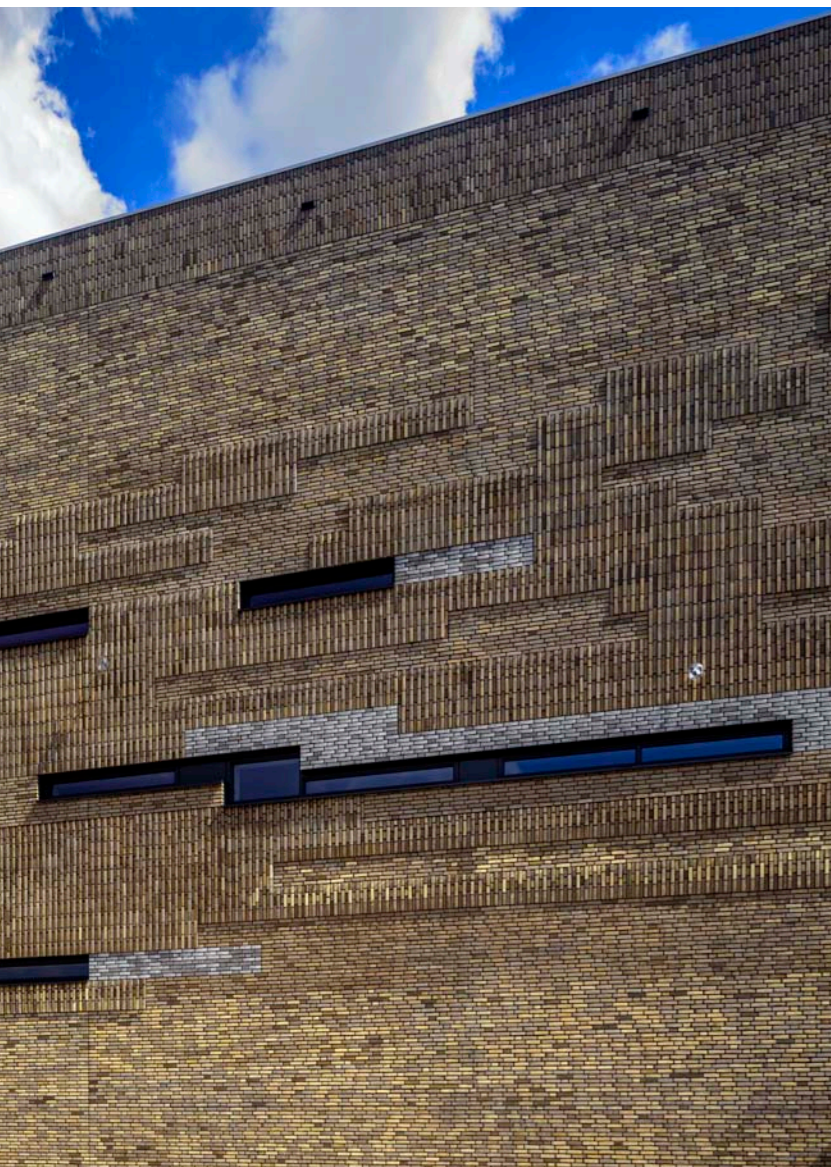
Het reliëf ontstaat door de bakstenen twee centimeter terug en naar buiten te leggen.
