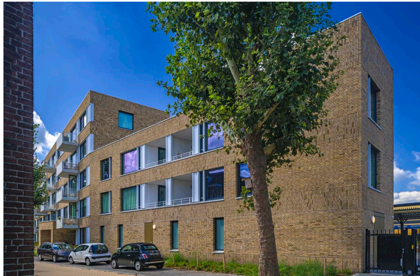
De dichte achterzijde contrasteert met een open voorzijde. Ook hier is werk gemaakt van het metselwerk. Foto's: johnlewismarshall.com
