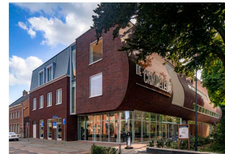
De gewelfde vorm van het entreegedeelte komt voort uit de stedenbouwkundige randvoorwaarde de gebouwschil zowel op de begane grond als op de bovenste laag terug te laten springen.
