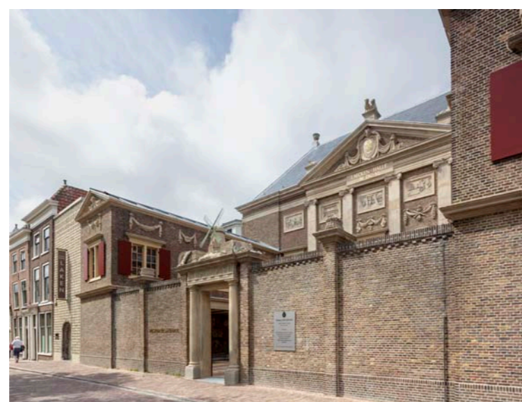
Aan de kant van de Oude Singel werd de knipvoeg in de monumentale buitenmuur uit IJsselstenen vervangen door een meer authentieke licht bollende boeren knipvoeg.
