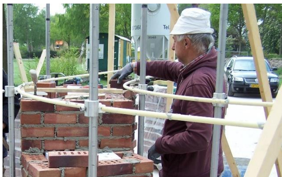
Bij 'De Muur Tegen Geweld' in Wolden is een systeem met kunststof elektrabuizen ingezet voor de realisatie van gebogen metselwerk.
