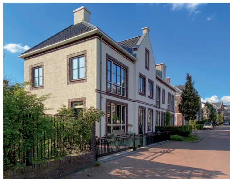
Bij schilderwerk op baksteenmetselwerk zijn vooral het sulfaatgehalte en de vorstbestandheid van de baksteen belangrijk. Nijmegen Bandoenstraat, Mulleners + Mulleners Architecten Amsterdam. Foto's: Arie Mooiman
