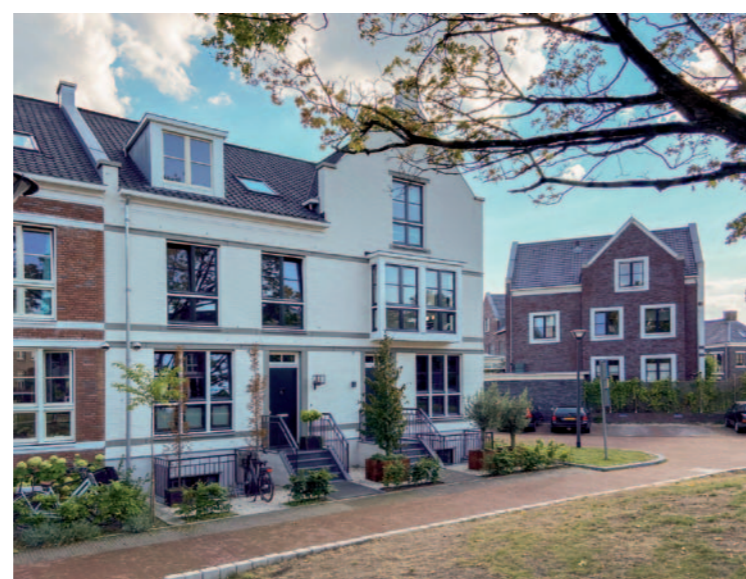
Er zijn verfproducenten die adviseren om bij nieuwbouw pas een jaar na het metselen eventueel te gaan schilderen.
