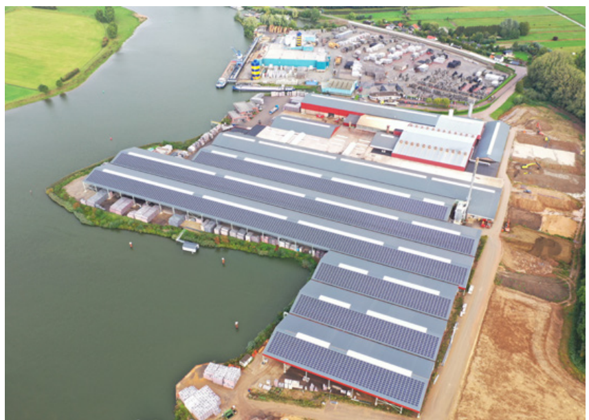
Steenfabriek met zonnepanelen
