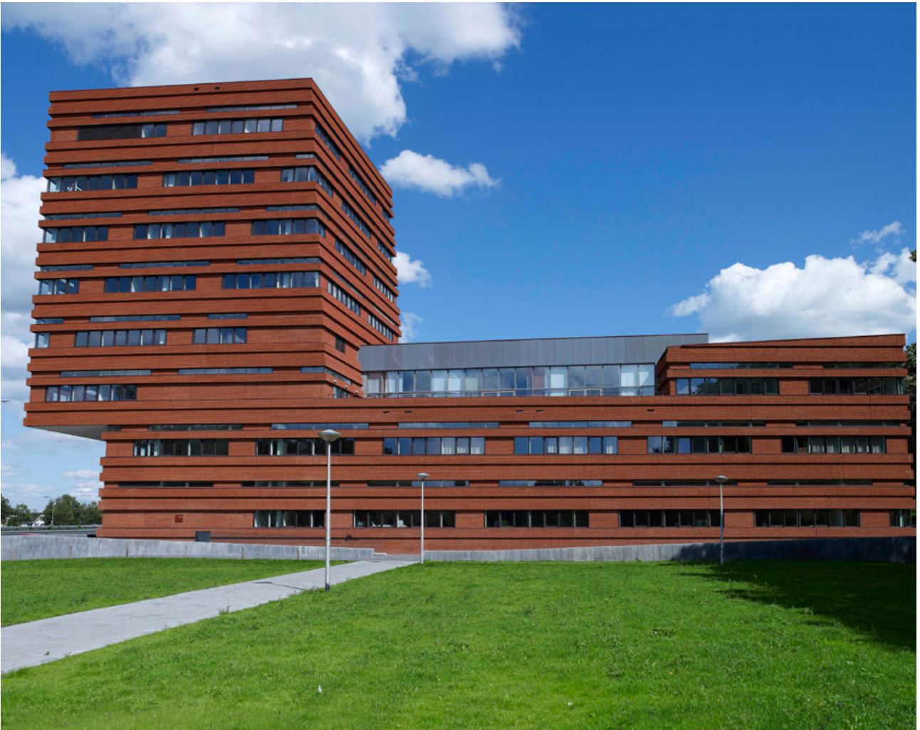
Gevel, grotendeels voorzien van keramische steenstrips
