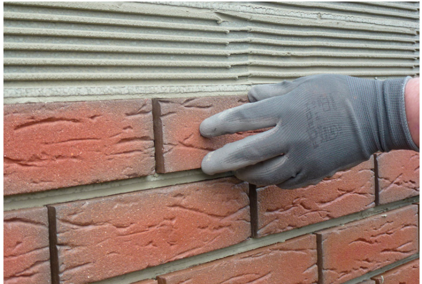
Het lijmen van keramische steenstrips
