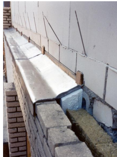
Afbeelding 1. Ondersteuning bladlood met EPS.
