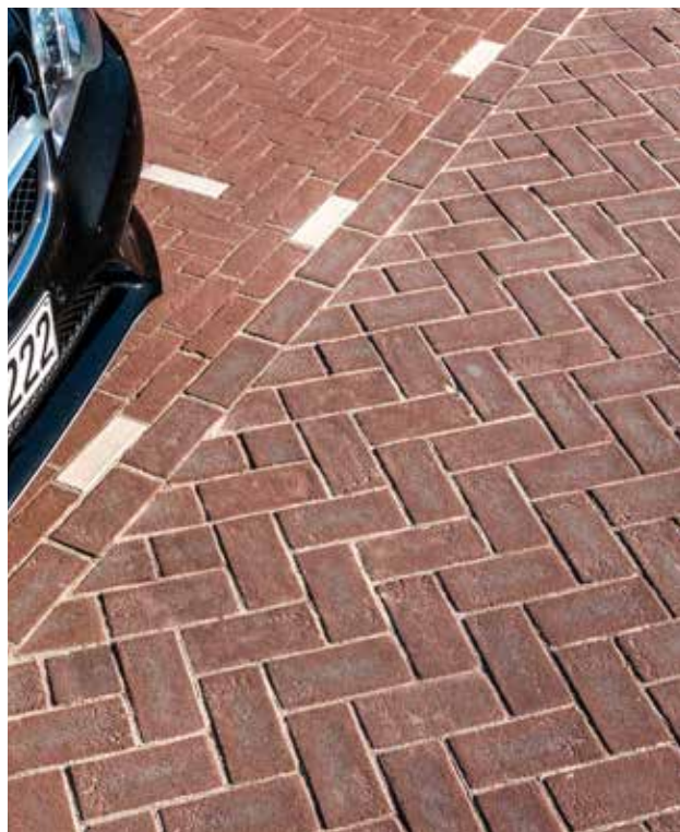
Gebruik van nieuwe en oude straatbakstenen, Boulevard Zuid, Egmond aan Zee.
