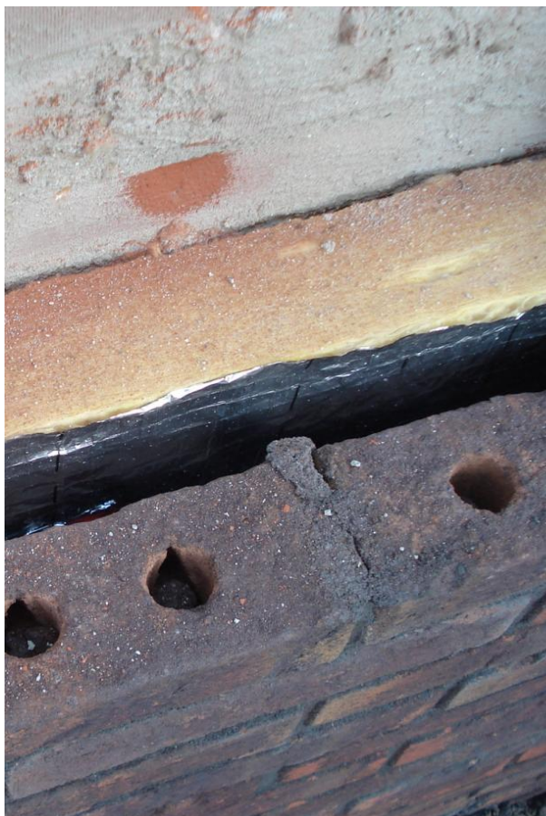
Gebruik van smalle baksteen bij renovatie
