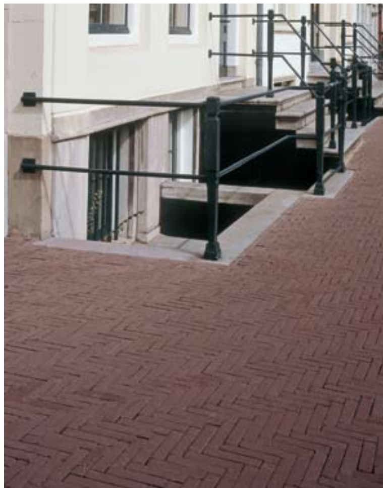
Op de Prinsengracht in Den Haag zijn de voetpaden in elleboogverband gelegd.
