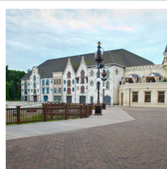
Alle vier de kades sluiten aan bij de bestaande bebouwing en omgeving.
