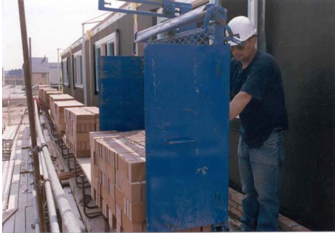
Figuur 10. Mechanisch transport van 12-voets pakketten op de bouwplaats.
