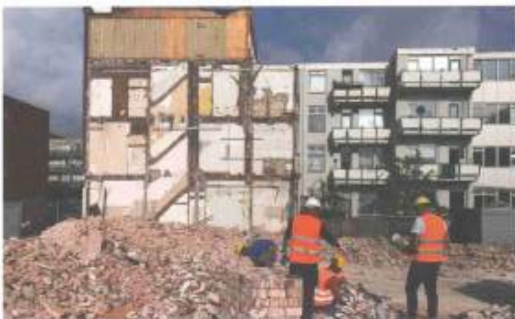
De slopers slopen het gebouw volgens de werkinstructies van de steenleverancier.
