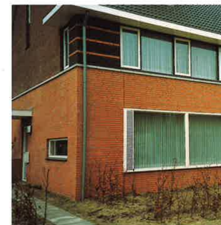
Dilatatie zelfdragende latei met onvoldoende stijfheid
