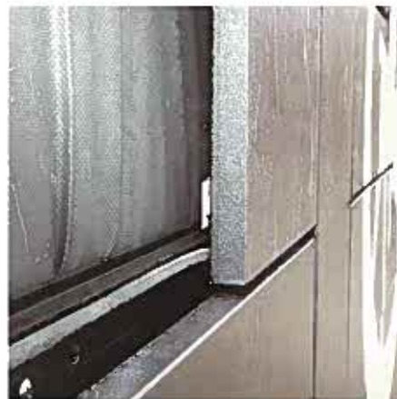
Figuur 10. Detail buitenisolatie met keramische platen
