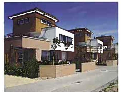
Figuur 21. Muurafdekkingen. Tuinmuur afgedekt met rollaag; dakterras afgedekt met prefab afdekprofiel
