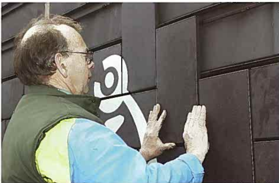
Figuur 9. Buitenisolatiesysteem met keramische gevelplaten (St. Joris)
