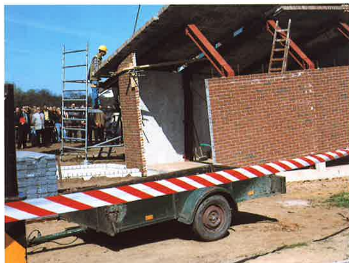
figuur 3 Voorgespannen geprefabriceerd gevelement
