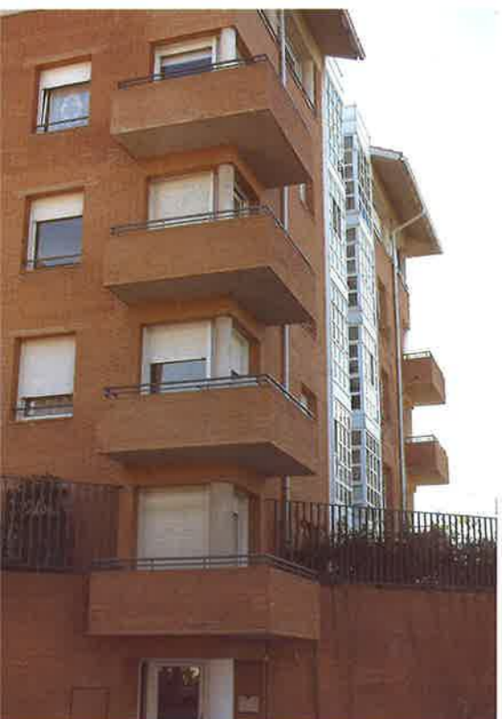
Figuur 16 Opgemetselde balkonafdeling (foto: Grid Design).
