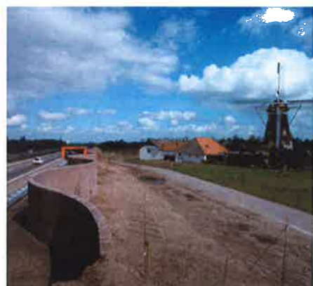
Figuur 9 Geluidsmuur met gebogen vorm.
