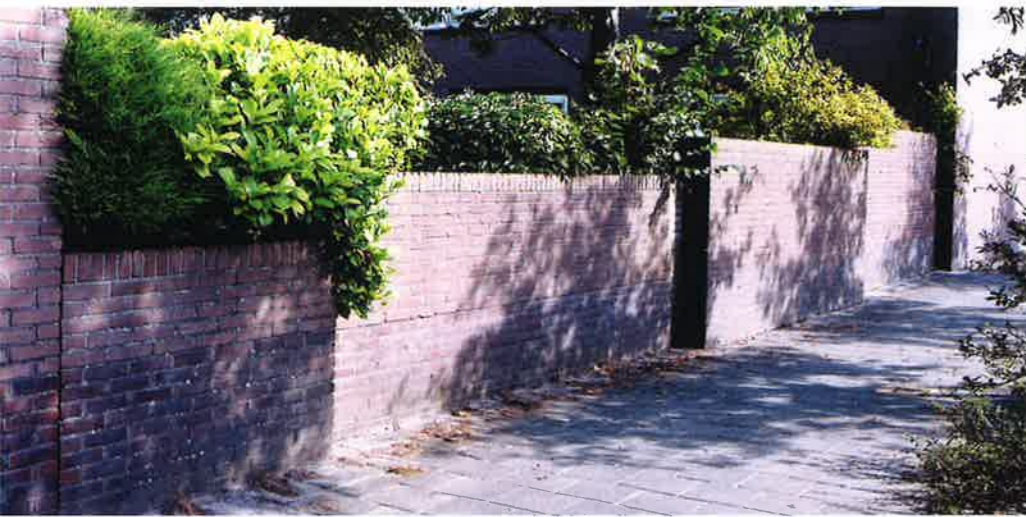
Figuur 4 Tuinmuur halfsteens met steens penanten. De halfsteens muren zijn wisselend aan voor- en achterzijde van de penanten geplaatst. (Foto: Grid Design)
