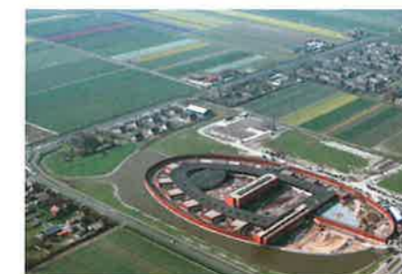
Figuur 14 Vrijstaande muur van ca 5 m hoog rond het complex van de RIJ 'De Doggersbank' in Den Helder. De muur is vervaardigd van gelijkde bakstenen. Architect: Loof & van Stigt architecten B.V., Amsterdam. Foto: Snow-White fotografie / Moniek Mulder, Weesp.
