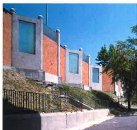
Figuur 10 Geluidsmuur met geknikte vorm.
