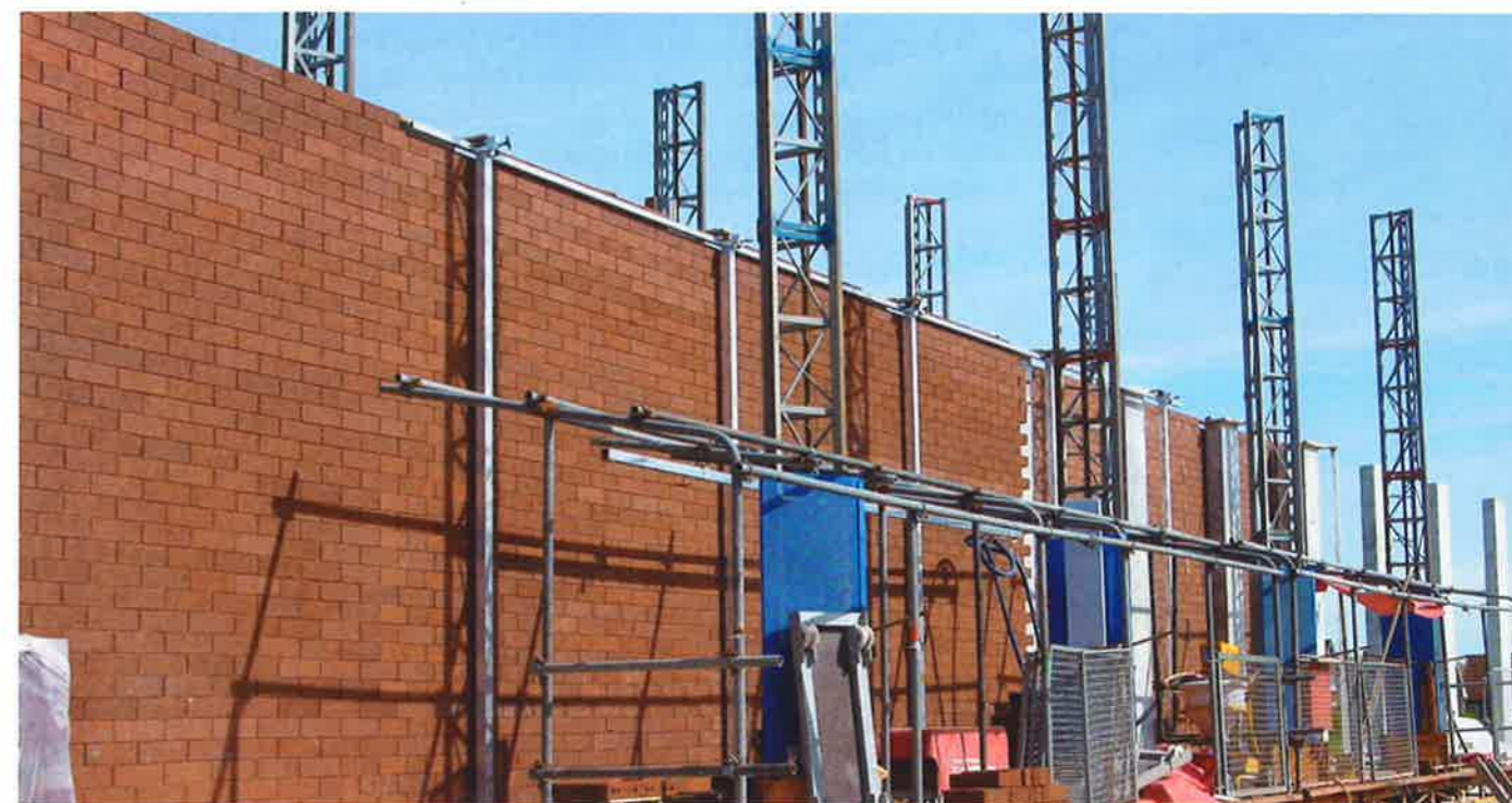
Figuur 15 De muur tijdens de uitvoering. De ellipsvormige ommuring van het complex is gebouwd als spouwmuur. De muur ontleent haar stabiliteit aan in de fundering ingeklemden kolommen, die in de brede spouw zijn opgenomen. De spouwbladen zijn met een folie losgebonden van de kolommen, zodat zij vrij kunnen bewegen bij temperatuurverschillen. De verrijdbare hefsteiger werd speciaal voor het project ontwikkeld. De muur heeft een totale lengte van 660 meter. Foto: Loof & van Stigt architecten B.V., Amsterdam.
